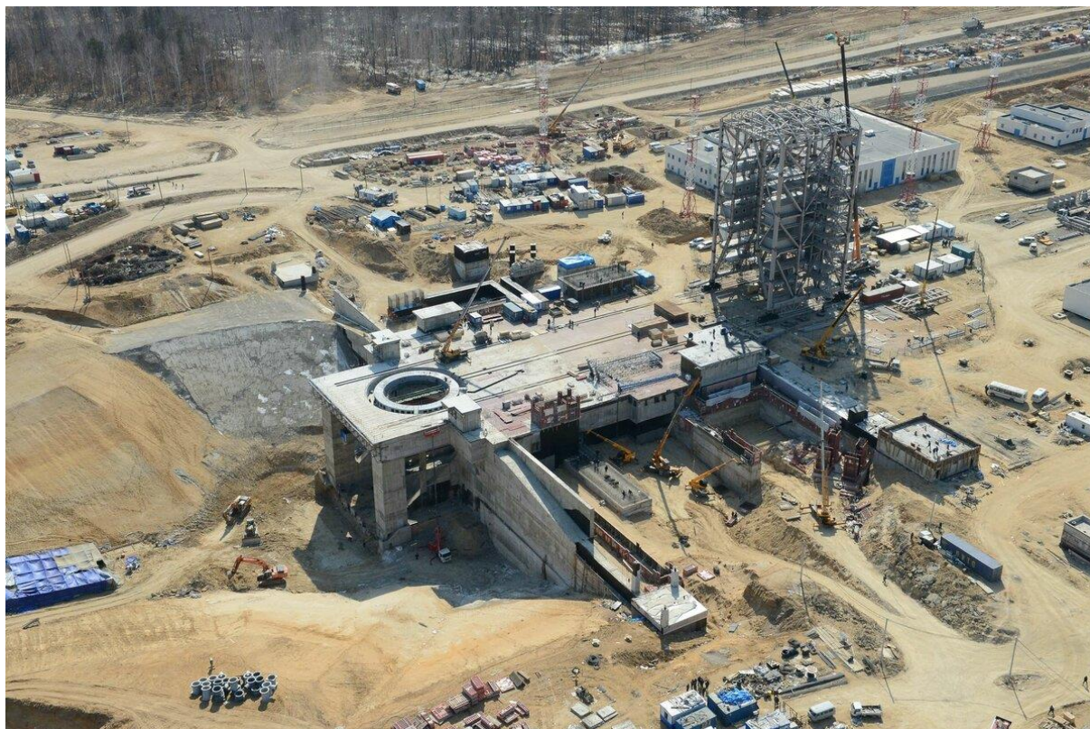
Рис. Строительство сооружений на космодроме «Восточный»
